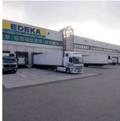
Schillerstraße 51, Ellhofen, Baden-Württemberg
